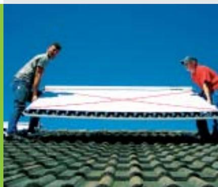
Ausnahmen: Citrin Solar ging mit drei Kollektoren ins Rennen, Paradigma mit nur einem, dafür aber relativ großen. Neun Anbieter starteten mit Flachkollektoren. Dreimal wählten wir Vakuumröhren, die sich dank Vakuumdämmung besonders im Winter stärker erwärmen.
